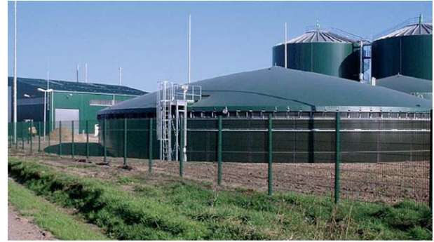
Resim N-09: Modern bir tesiste yeni usullere göre yapılan PARATONER yıldırımdan korunma örneği
