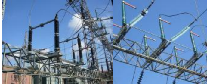
Resim 2.2: 154/36 kV trafo merkezinde kullanılan ayırıcılar
