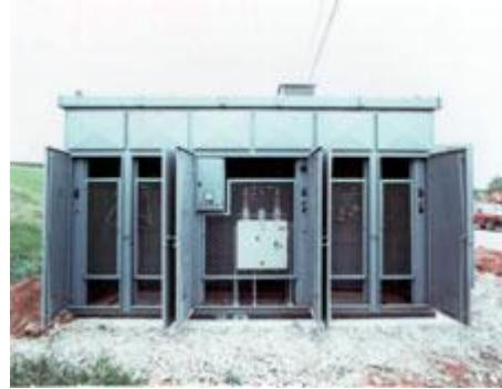
Resim 3.2: Metal köşk tipi trafo merkezi 1
