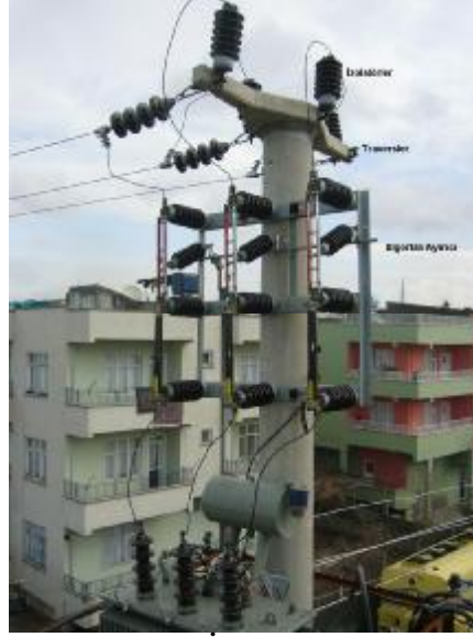
Resim 1.10: İzolatör ve travers
