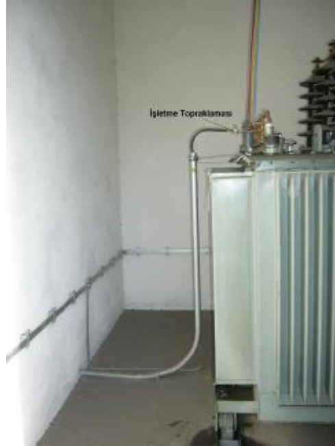
Resim 3.20: İşletme topraklamasının trafoya bağlantısı
