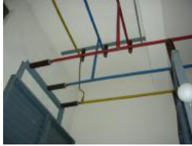
Resim 3.5: Bina tipinde kullanılan baralar
