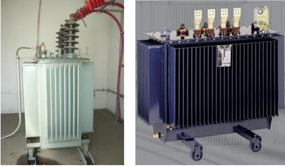
Resim 3.4: Bina tipi güç trafosu
