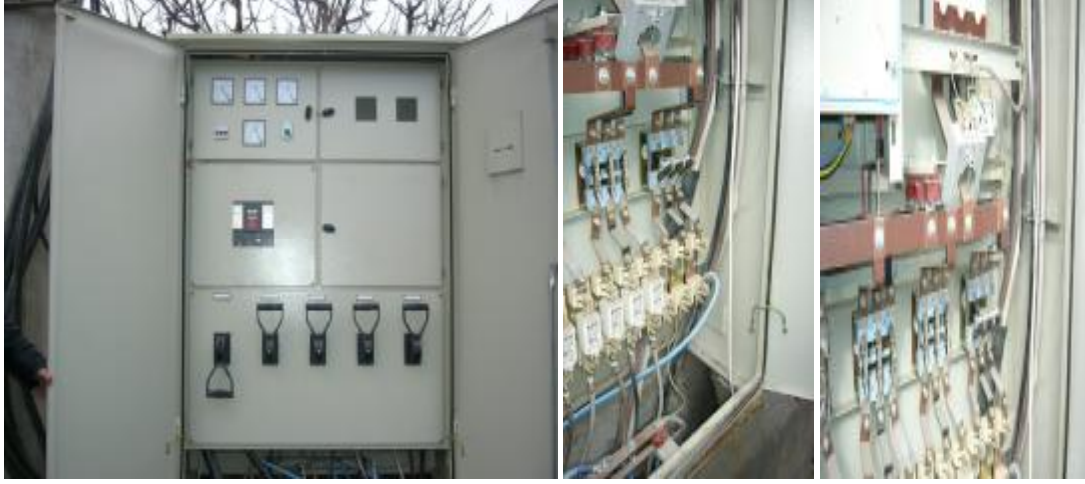
Resim 1.12: Panonun önden görünüşü, arka görünüş ve elemanların bağlantısı
