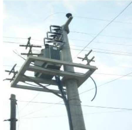
Resim1.6: Trafonun beton direğe yerleşimi
