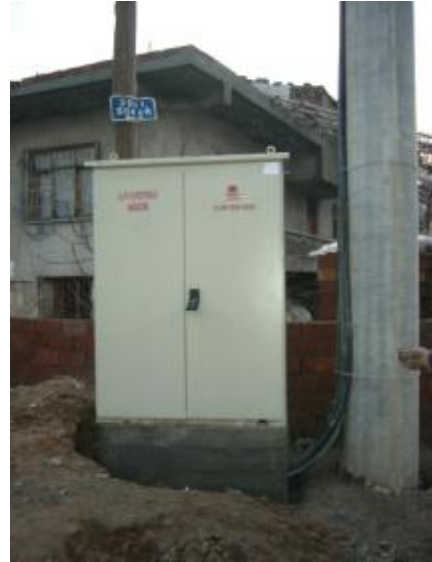
Resim 1.11: Direk tipi trafo ölçüm panosu
