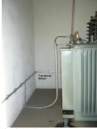
Resim 3.11: Topraklama bağlantısı
