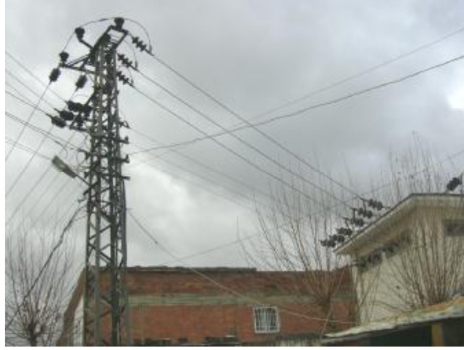
Resim 3.17: Direk ile trafo binası arasındaki hava hattı bağlantısı
