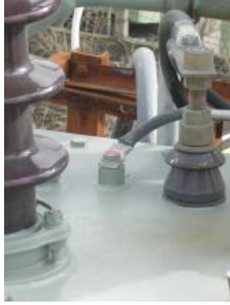
Resim 1.14.a: Trafo toprak bağlantısı
