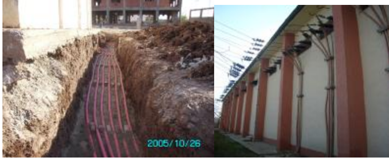
Resim 3.18: Trafo binasının yeraltı kablosu ile bağlantısı
