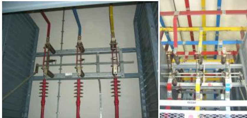
Resim 3.10: Bina içinde kullanılan ayırıcılar
