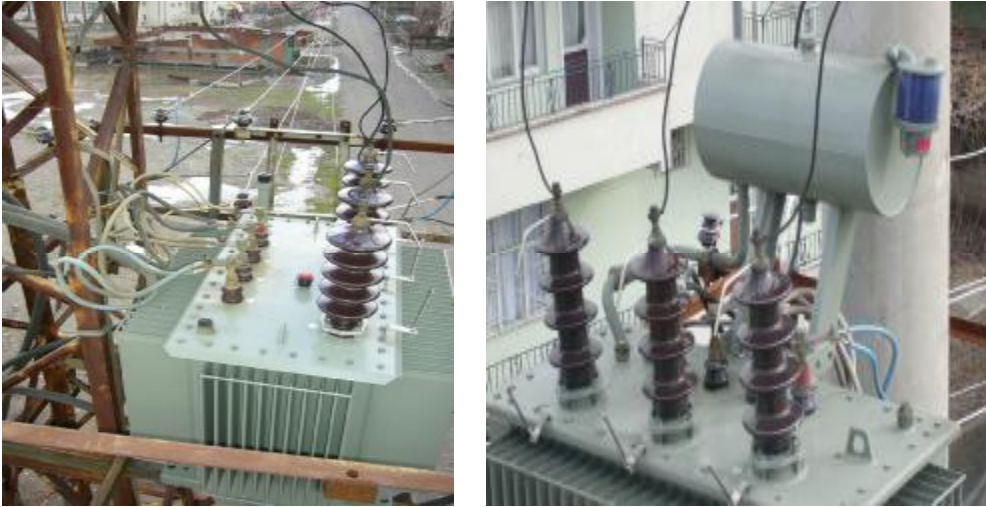
Resim 1.14: Trafo giriş ve çıkış bağlantıları
