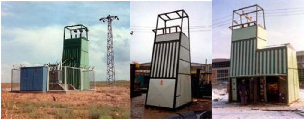
Resim 3.1: 34,5 kV havai hat girişli kule tipi indirici merkezleri
