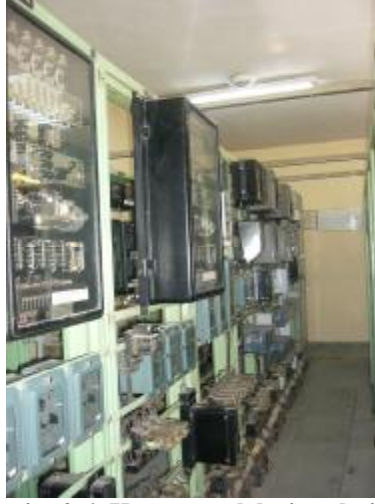
Resim 2.6: Koruma röleleri yerleşimi
