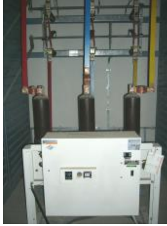
Resim 3.9: Bina içinde kurulmuş kesici
