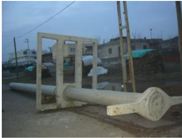
Resim 1.3: Beton direğe ait trafo platformu
