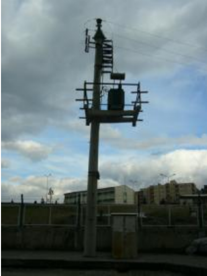
Resim 1.11: Direk tipi trafo ölçüm panosu
