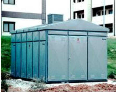
Resim 3.2: Metal köşk tipi trafo merkezi 1
