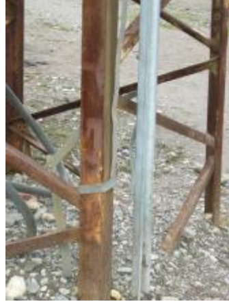
b: Topraklama iletkeninin topraklama çubuğuna bağlantısı
