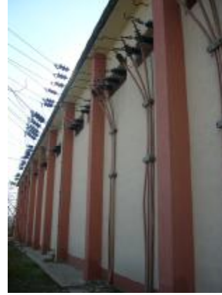
Resim 2.14: Yeraltı kablosunun yerleşimi ve bina içine bağlantısı
