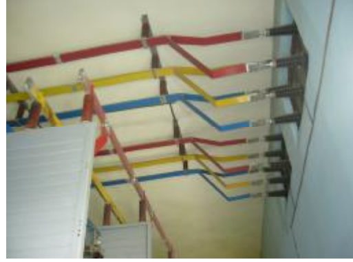
Resim 2.13: Hava hattı ile enerjinin binaya girişi ve bina içi bağlantısı
