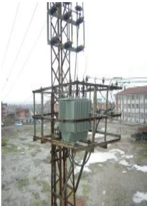
Resim 1.1: 250 kVA demir trafo direği ve platformu
