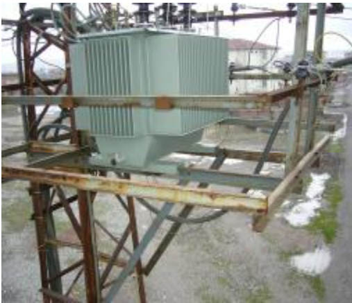
Resim 1.5: Trafonun demir direğe yerleşimi
