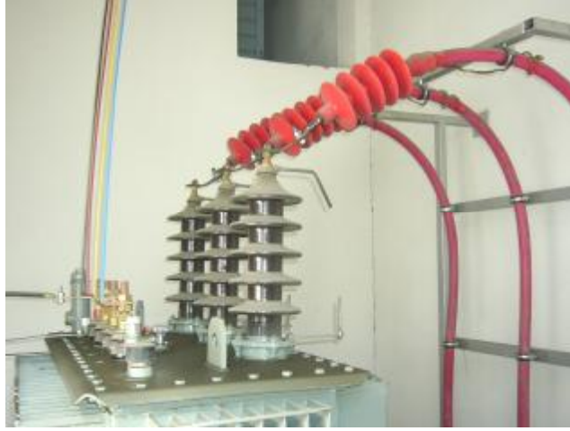
Resim 3.19: AG ve OG iletkenlerin trafoya bağlantısı
