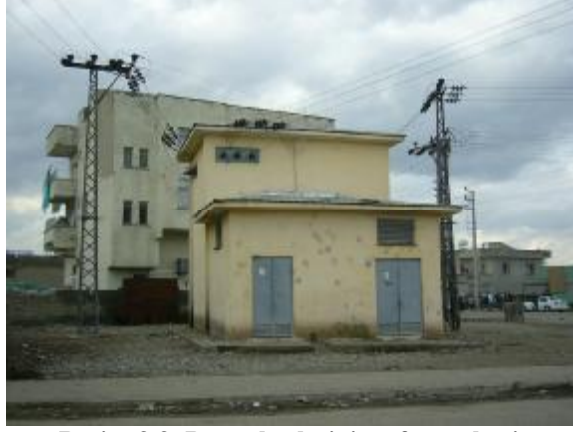
Resim 3.3: Beton köşk tipi trafo merkezi
