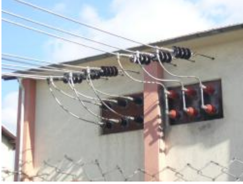
Resim 2.13: Hava hattı ile enerjinin binaya girişi ve bina içi bağlantısı
