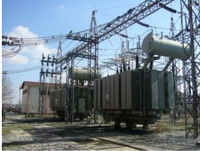
Resim 2.1: 100 MVA 154/36kV güç trafosu
