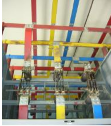
Resim 2.7: Bina içinde kullanılan baralar
