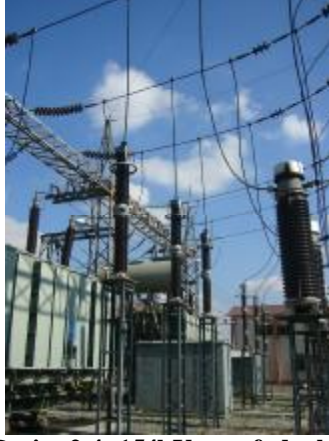
Resim 2.4: 154kV parafudurlar
