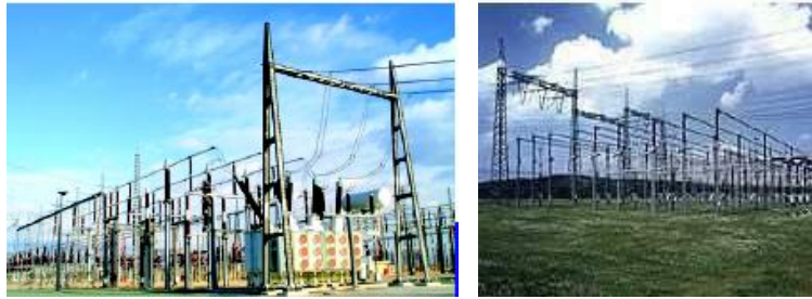
Şekil 2.1: Açık şalt sahası
