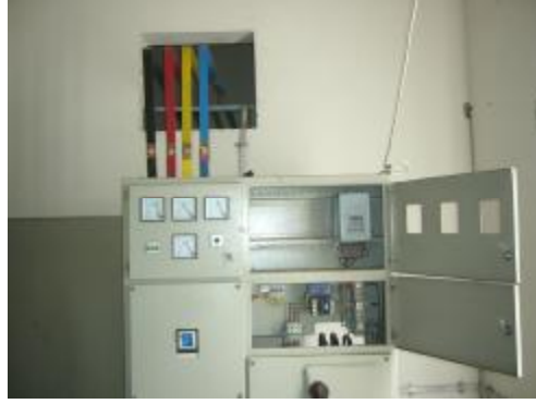
Resim 3.12: AG panosunun baraya bağlantısı
