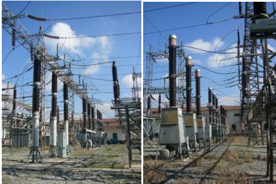
a) 154kV SF6 gazlı kesici b) 154kV havalı kesici
