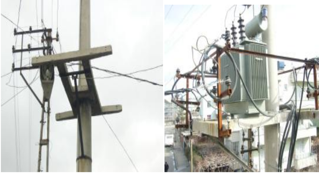
Resim 1.2: Beton direk trafo platformu ve trafonun platforma yerleşimi
