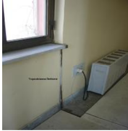
Resim 2.5: Trafo merkezlerinde bina topraklama iletkeni
