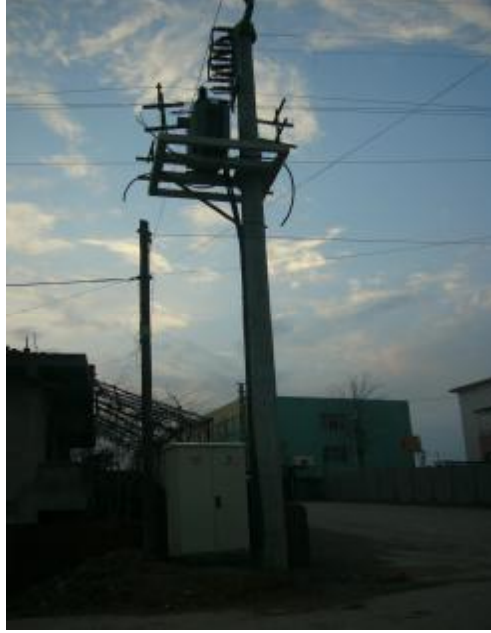
Resim 1.4: Beton direk tipi trafo postası
