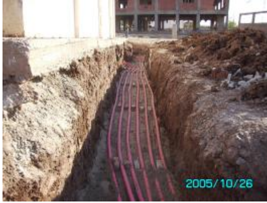
Resim 2.14: Yeraltı kablosunun yerleşimi ve bina içine bağlantısı
