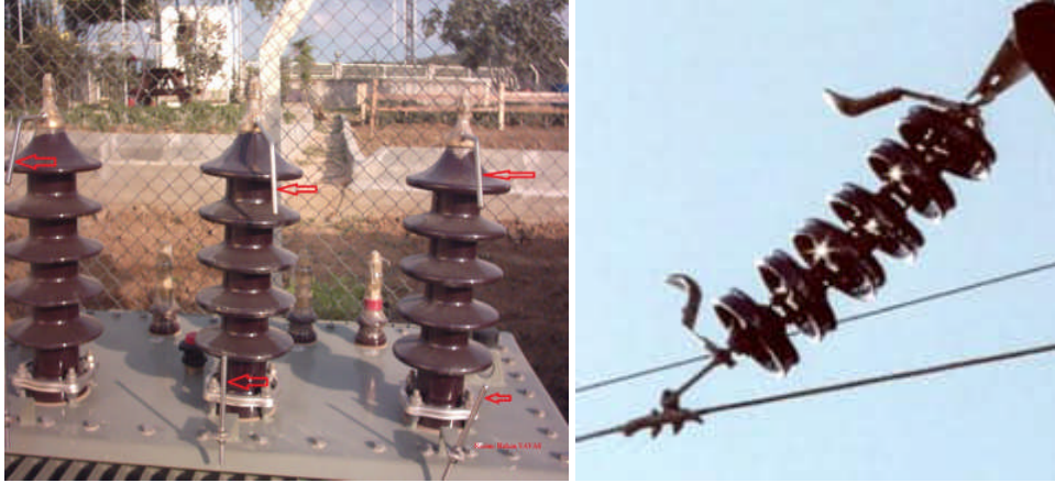
Resim 4.2: Trafo buşing ark boynuzu ve zincir tipi izolatör ve ark boynuzları
