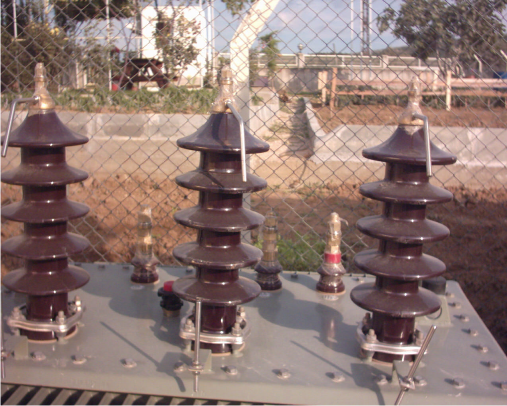
Resim 1.15 : Transformatör buşing izolatörü
