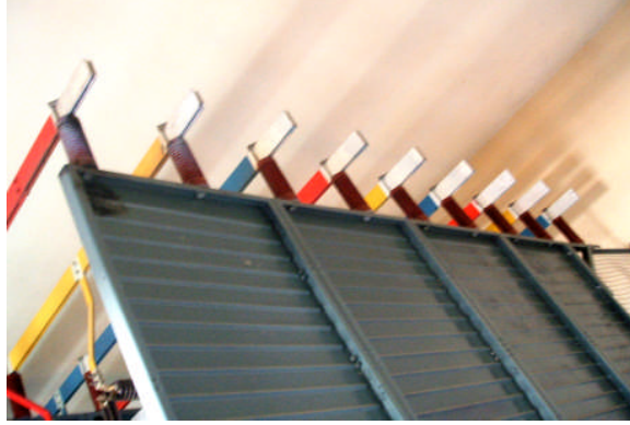
Resim 3.1: Mesnet tipi izolatörler ve baralar
