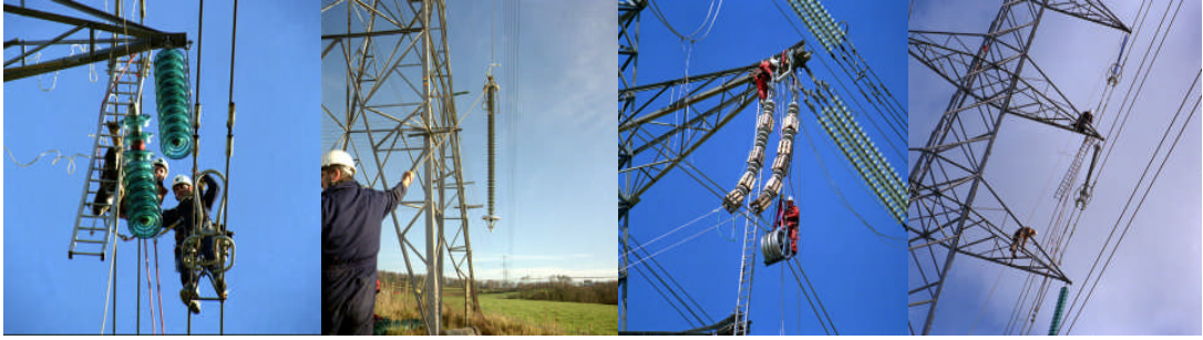
Resim 2.4: Havai hatlarda izolatör montajı
