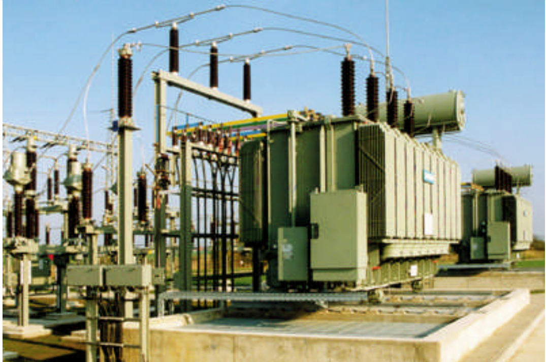
Resim 1.16: Yüksek gerilim şalt sahası
