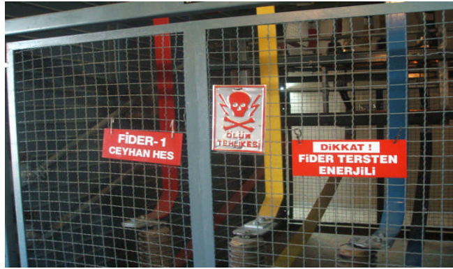
Resim 3.3: Trafo binası güvenlik ve uyarı levhaları
