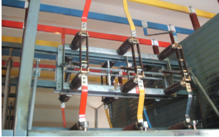
Resim 3.5: Ayırıcılarda kullanılan mesnet izolatörleri
