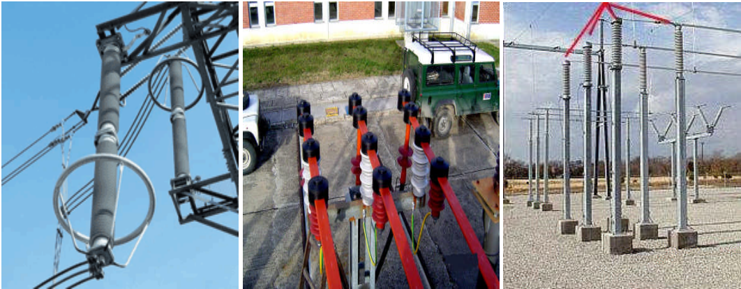
Resim 2.9: Parafudur bağlantıları
