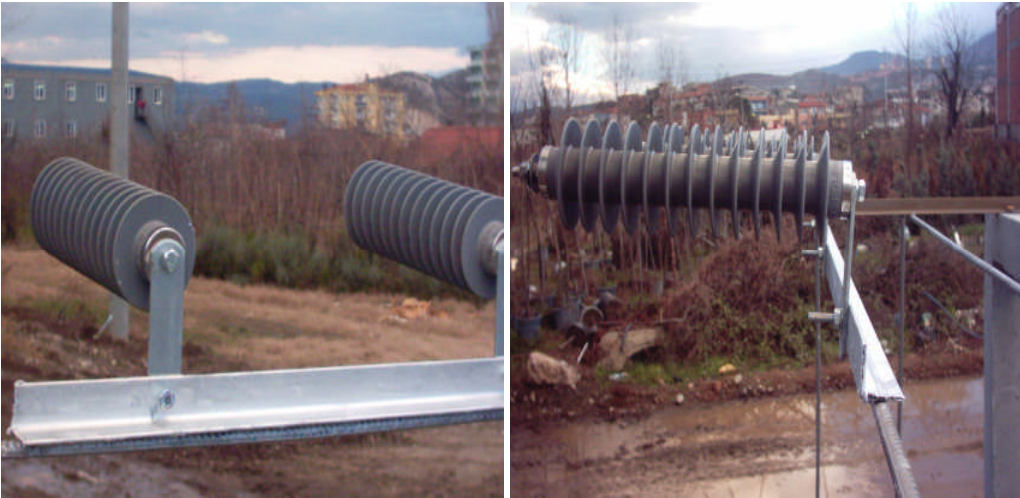
Resim 2.5: Demir (galvanizli) lamaya parafudur montajı
