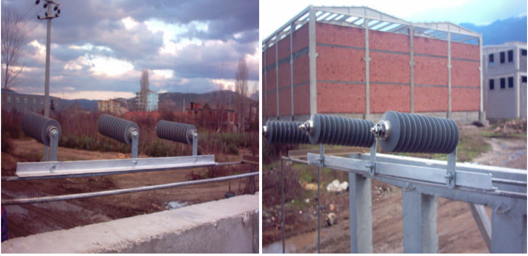
Resim 2.6: Parafudurun yerine montajı
