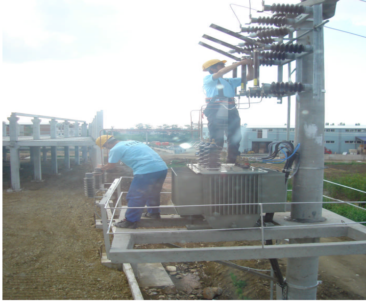
Resim 3.8: Trafo direğinde sigorta montajı
