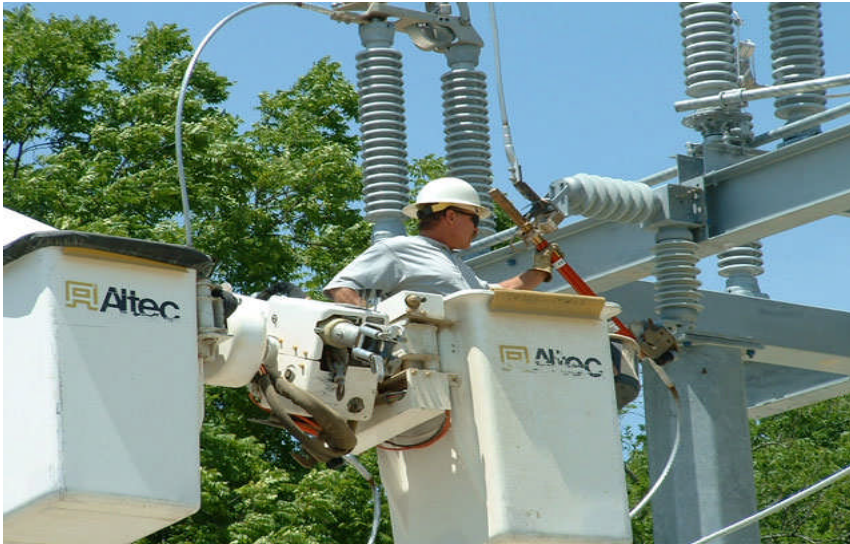
Resim 3.5: YG Sigortasının takılması
